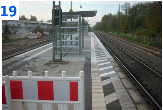
Bahnsteig-Verlängerung in Rot-Malsch für Dreifachtraktionen der S3/S4; Fotos: Martin Theodor Ludwig
