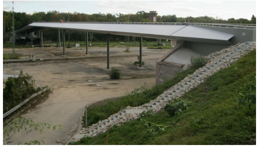
Beim Blick auf die neue Brücke von der aus der Südstadt kommenden Rampe aus erkennt man den Knick an der höchsten Stelle. Die breiten seitlichen Verkleidungen der Brücke beinhalten Kabel und dienen als Schutz vor dem Berühren der darunter befindlichen Bahn-Oberleitungen.
