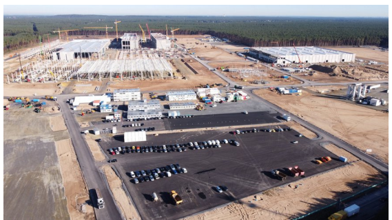
Blick auf das Gelände der in Bau befindlichen Tesla Gigafactory Berlin-Brandenburg: Sehr viel Flächenverbrauch für immer noch viel zu viel MIV; Foto: Michael Wolf, Penig, Bildlizenz: CC by-sa 3.0, Details dazu siehe Wikimedia
